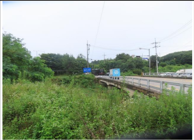
송수-2구간 하천횡단부 전경
