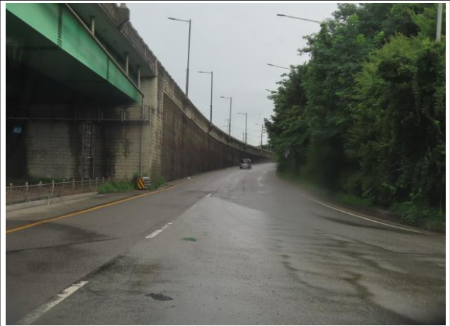
송수-4구간 시점부 전경
