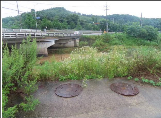
송수-1구간 하천횡단부 전경
