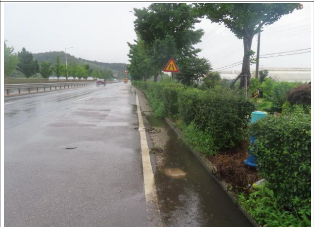
송수-6구간 시점부 전경
