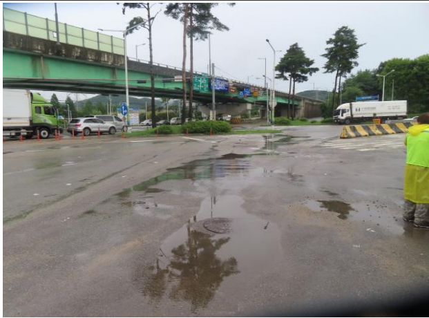
송수-3구간 시점부 전경
