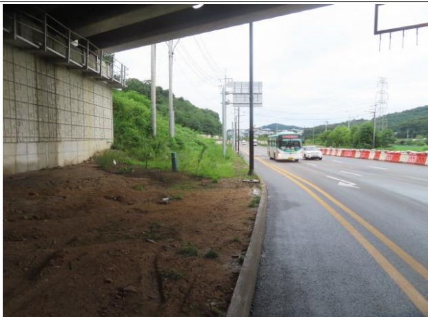
송수-5구간 시점부 전경
